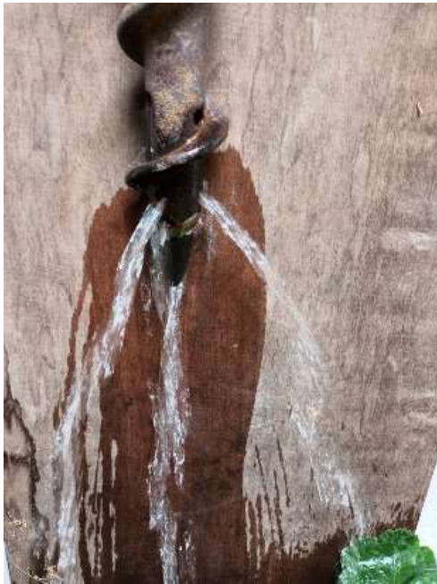
Photo 9. The outlet of water at the bottom of the drill. La salida de agua en la parte inferior del taladro.
