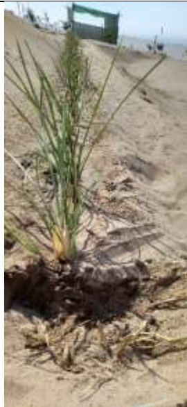
Photo 5. This vetiver was planted 4 weeks ago on top of the vetiver biorope. Este vetiver fue plantado hace 4 semanas encima de vetiver biorope
