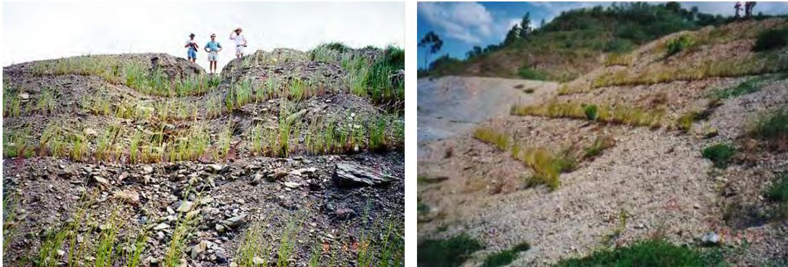
**Figura 52.** El Vetiver creció en las curvas de nivel de las laderas de un vertedero de escombros reciente de una mina de carbón.
