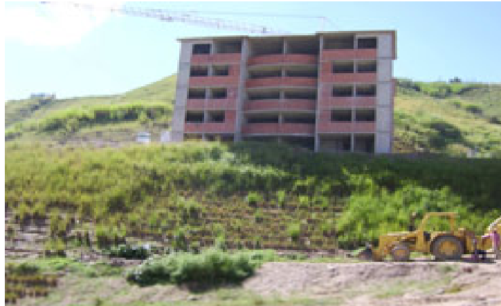
Figura 50. Plantado de vetiver alrededor de edificios
