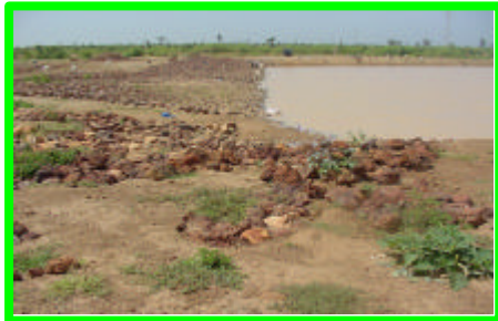
Protection mécanique inefficace contre l'envasement du bassin
