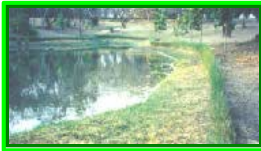
Protection d'un bassin de rétention par le vétiver
