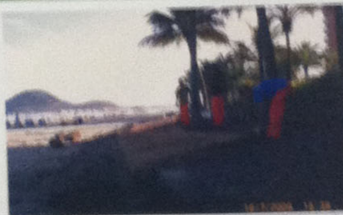
Figura 5: Leiras de proteção, com retentores de sedimentos tipo Bernalonga Ø 50. Fonte: Deflor Bioengenharia
