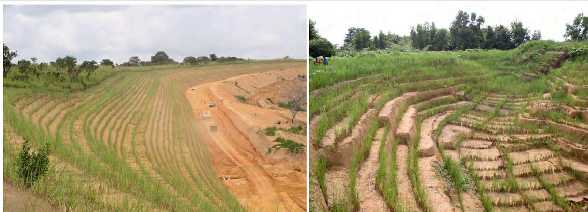
Barreras de vetiver protegiendo taludes de corte en autopista (izquierda) y, la estabilización de una cárcava(derecha), ambos en el Congo.
