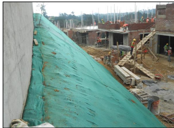
Imagen 7: Geomanto sintético anclado en talud. Antigua, Julio, 2011
