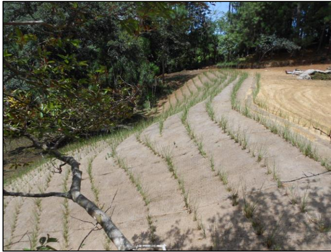
Imagen 3: Geomanto biodegradable y Sistema Vetiver. Cobán. 2013
