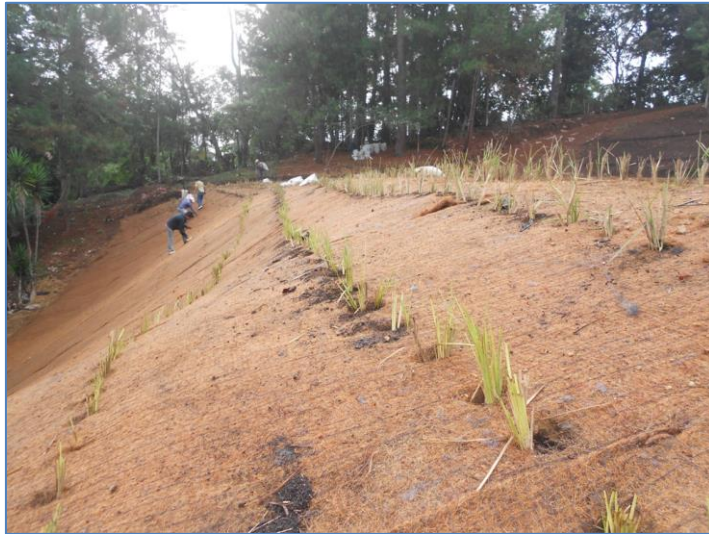
Imagen 8: Instalación del Sistema Vetiver. Cobán, Junio 2013
