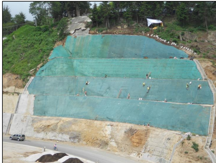
Imagen 5: Instalación de germano sintético, Fraijanes, Febrero 2013
