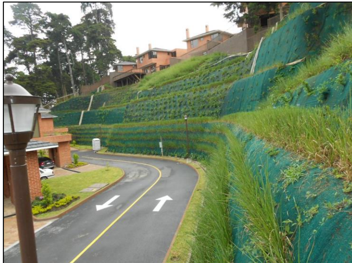
Imagen 11: Taludes protegidos con Geomanto y Sistema Vetiver. Concepción, Junio 2013
