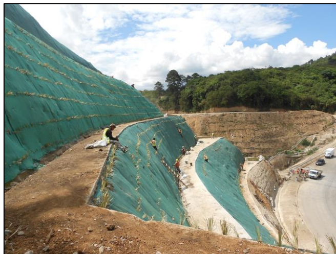
Imagen 9: Instalación del Sistema Vetiver. Fraijanes, Mayo 2013.
