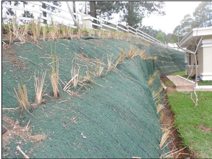
Imagen 12: Protección de talud en residencia. Carchá, abril 2013.
