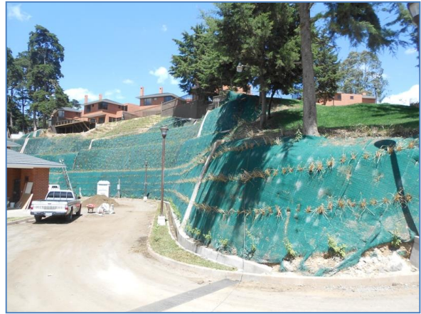
Imagen 2: Geomanto sintético instalado. Concepción, Febrero 2013.
