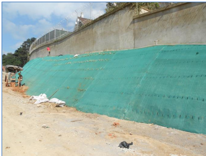
Imagen 4: Geomanto sintético instalado. Guatemala, 2012
