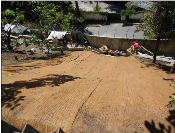
Imagen 1: Geomanto Biodegradable instalado. Guatemala, Mayo 2010.
