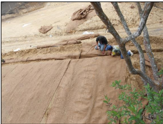
Imagen 6: Zanja de anclaje del germano. Quetzaltenango, Diciembre 2010
