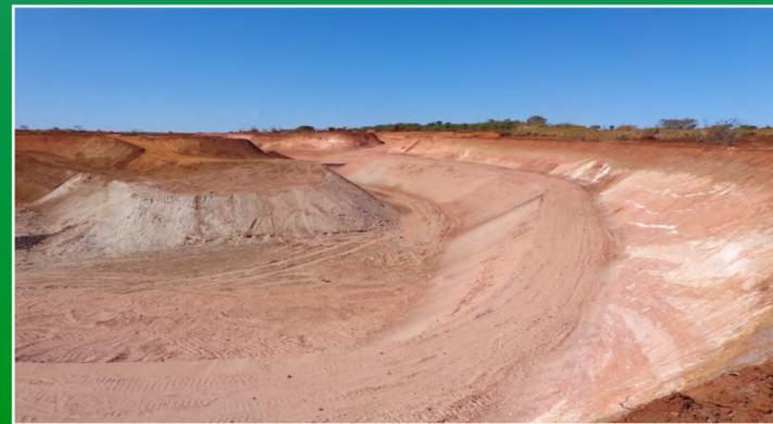
Foto 4 – Início do retaludamento das paredes da erosão
