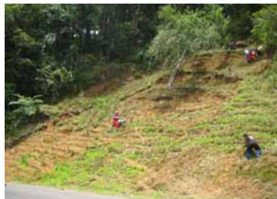
Figura 12: Sistema Vetiver fue aplicado para estabilizar y detener movimientos de suelo en talud de carretera (Ruta N ° 1249).
