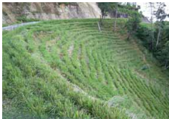
Figure 2: Terraplén de la carretera (pendiente lateral) se estabiliza con vetiver.
