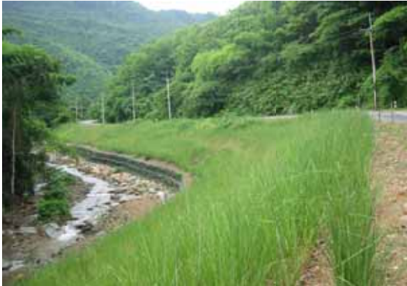
Figura 5: Siembra de Vetiver en hombro de carretera con fuerte pendiente para reducir la velocidad de la escorrentía longitudinal.
