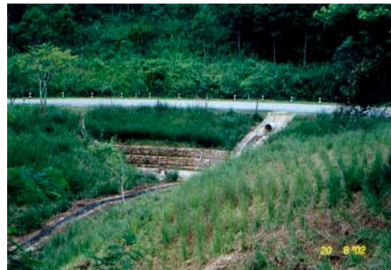
Figura 6: SV asociado con muro de gaviones en trabajos de rehabilitación.
