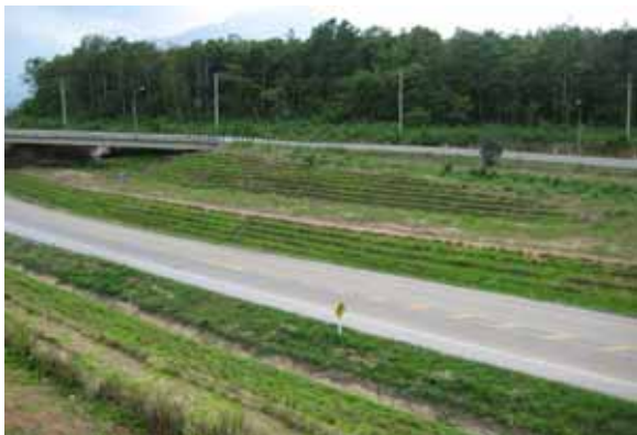
Figure 1: Talud en corte de carretera (ladera) fue estabilizado con Vetiver
