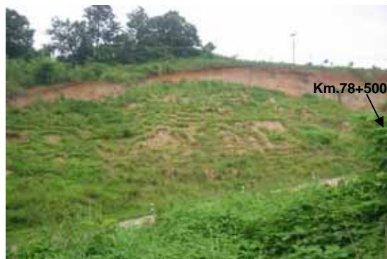
Figura 14: SV en la estabilización de una pendiente con suelo saturado por agua para detener el flujo de deslizamientos.
