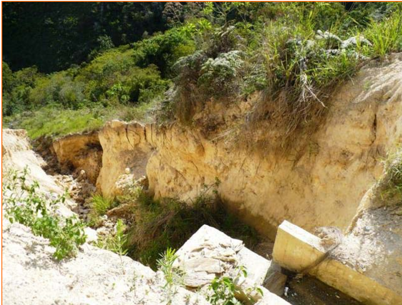
Cárcava Profunda en Minalba
