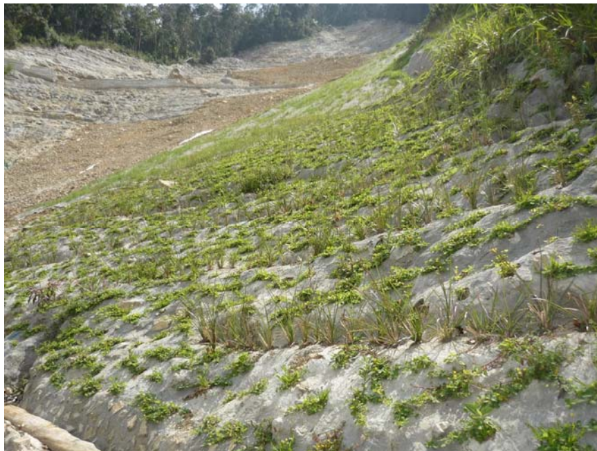
Mortero Ecológico, Vetiver y maní forrajero Autopista de montana “Las Palmas” Km 1+500 - Medellin. Antioquia
