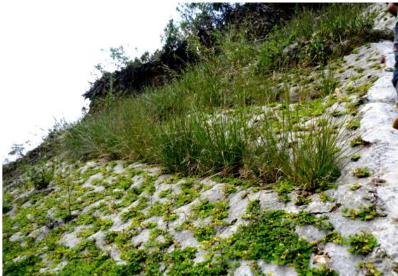
Mortero Ecológico, Vetiver y maní forrajero (Arachis Pintoi) Autopista de montana "Las Palmas" Km 1+500 - Medellin. Antioquia
