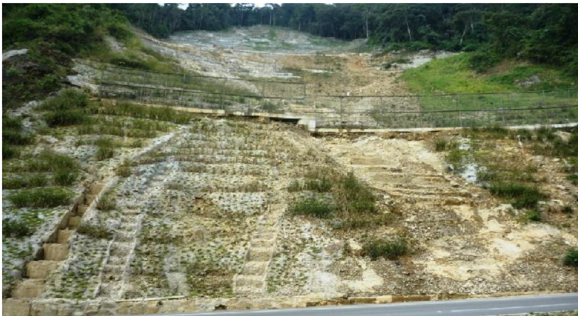
Mortero Ecológico, Vetiver y maní forrajero Autopista de montaña “Las Palmas” Sector Los Balsos- Medellín. Antioquia
