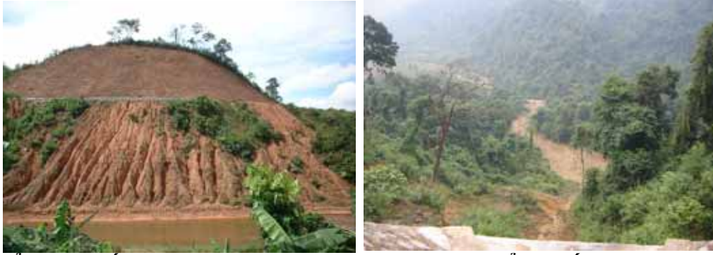
Ảnh 21: Đất đá thải ra bờ bãi khi làm đường có thể bị cuốn trôi theo sông suối (trái) và di chuyển rất nhanh xuống hạ lưu nếu không được cỏ Vetiver bảo vệ (phải).
