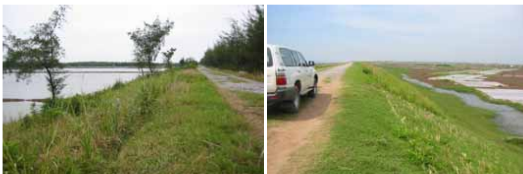
Ảnh 19: Thử nghiệm cỏ Vetiver bảo vệ mái ngoài hệ thống đê biển mới đắp ở Hải Hậu (trái); Nhưng cỏ Vetiver đã được trồng bảo vệ mái trong đê biển từ trước đó 1-2 năm (phải)
