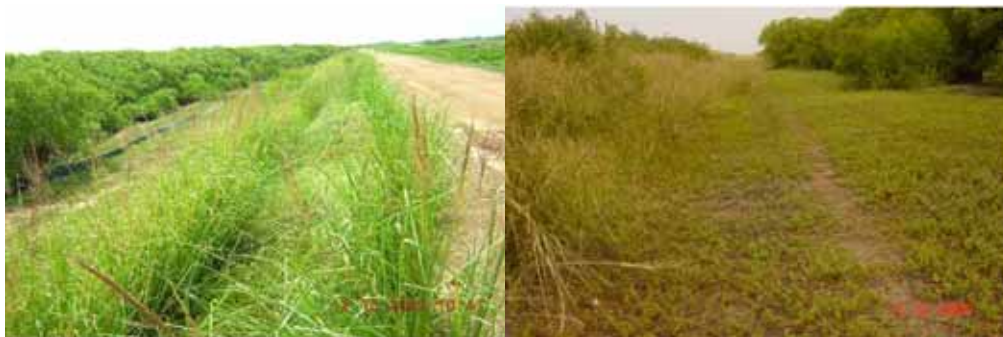
Ảnh 18: Cỏ Vetiver trên đất chua phèn hệ thống đê biển Gò Công, phía sau rừng đước (trái), giúp giảm nhẹ xói lở mái đê và tạo điều kiện cho cây cỏ bản địa phục hồi (phải)
