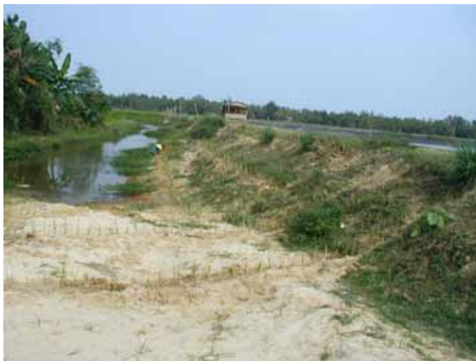
Ảnh 23: Bảo vệ đầm tôm cạnh ruộng thoát lũ từ đồng ra sông Vĩnh Điện (Đà Nẵng) - dự án thử nghiệm do Đại sứ quán Hà Lan tại Việt Nam tài trợ.
