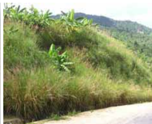
Ảnh 23: Chỉ sau vài trận mưa, taluy mới mở đã bị xói mòn, rửa trôi nghiêm trọng (trái) và cỏ Vetiver được trồng để bảo vệ (phải). Sau 8 tháng cỏ đã mọc tốt, ổn định được taluy, ngăn chặn hoàn toàn xói mòn, rửa trôi
