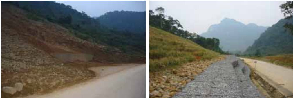
Ảnh 22: Taluy đường liên tục trượt lở, dồn đất đá xuống gây tắc đường (trái) nhưng cỏ Vetiver góp phần làm chậm lại và giảm đáng kể quy mô trượt lở (phải).
