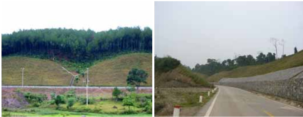
Ảnh 20: Cỏ Vetiver trồng bảo vệ taluy đường dọc tuyến đường Hồ Chí Minh, độc lập hoặc kết hợp với các biện pháp truyền thống khác.
