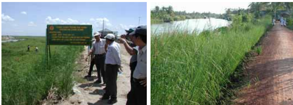
Ảnh 16: Cỏ Vetiver bảo vệ đê sông (trái) và bờ sông, bờ kênh (phải) ở An Giang
