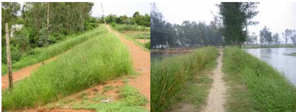
Ảnh 13: Bảo vệ mái trong một đoạn đê ngăn mặn khác (trái); và một đoạn kênh thủy lợi (Phải)
