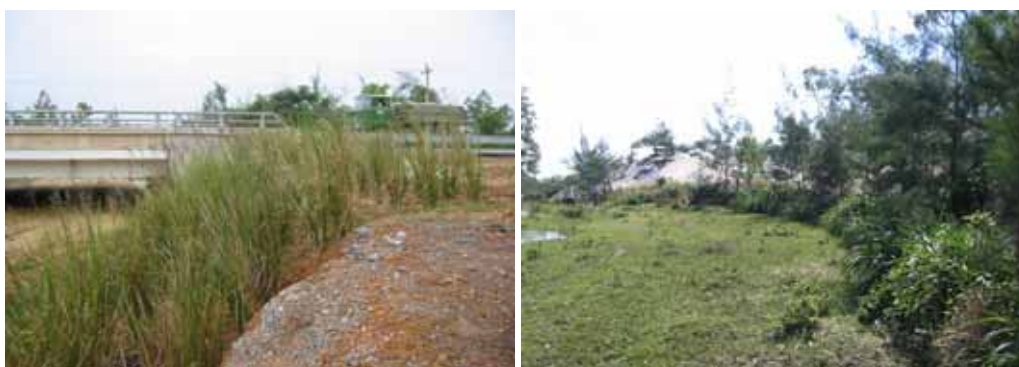
Ảnh 7: Bảo vệ móng cầu dọc quốc lộ 1 (trái); Các loài cây bản địa thay thế - Tháng 12/2004 (phải)
