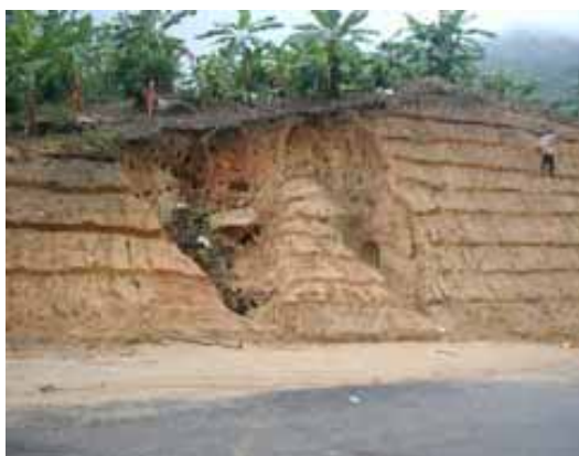
Ảnh 23: Chỉ sau vài trận mưa, taluy mới mở đã bị xói mòn, rửa trôi nghiêm trọng (trái) và cỏ Vetiver được trồng để bảo vệ (phải). Sau 8 tháng cỏ đã mọc tốt, ổn định được taluy, ngăn chặn hoàn toàn xói mòn, rửa trôi
