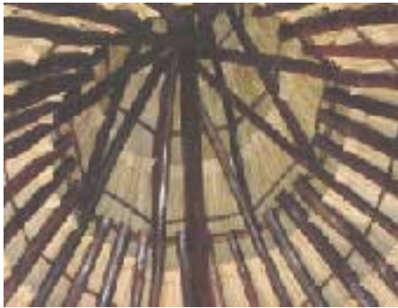
Vista interna del techo
