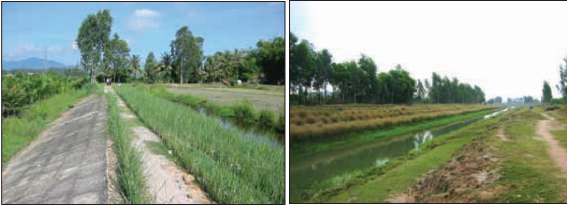
Picha ya 12: Kushoto: Kwa upande wa juu sehemu ya handaki la kuzuia umunyu kwenye sehemu ya mawemawe inayokabiliwa na mto. Kulia: kandokando ya sehemu ya mfereji wa kunyunyiza maji mmomonyoko wa juujuu unaharibu ng'ambo ile ya pili.
