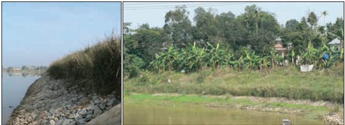
Picha ya 10: Kushoto: Vetiver na mawemawe (kwa juu) na fremu ya saruji (kwa chini) ikikinga mwinuo. Kulia: kona katika ukingo wa mto Perfume katika Hue.
