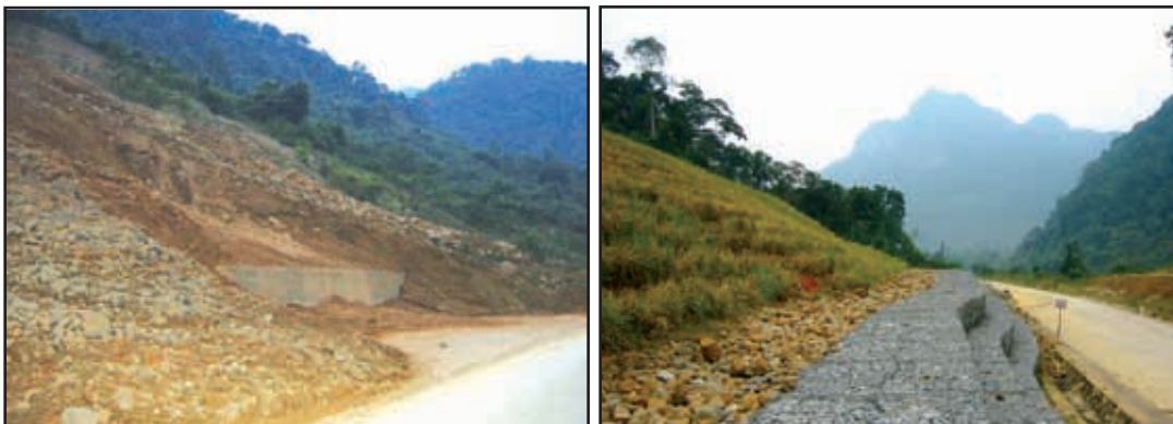
Picha ya 21: Mwanja wa Da Deo huko Quang Binh; Kushoto: Mimea imeharibiwa, inaonyesha mandhari mbovu na uharibifu ulioendelea wa miteremko iliyobuniwa. Kulia: mistari ya Vetiver juu ya mteremko ukishuka chini pole pole, huku ukipunguza sana maporomoko.
