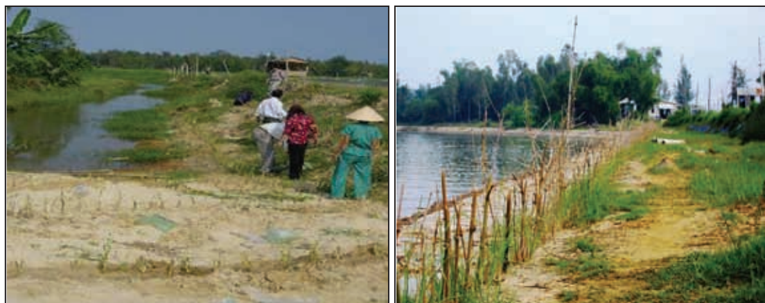
Picha ya 8: Kushoto: Marchi 2002 majaribio ya upanzi wa Vetiver kwenye ukingo wa kidimbwi cha kamba wadogo ambamo mfereji hupeleka maji ya mafuriko kwenye mto Vinh Dien. Kulia: Novemba 2002: kupanda kwa wingi VS ikitumiwa pamoja na mawemawe ili kukinga ukingo wa mto Vinh Dien.
