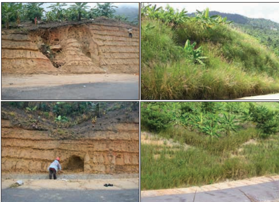
Picha ya 22: Picha mbili za kushoto: Pham Hong Duc Phuoc, mradi wa ukingaji barabara mkoani Khanh Hao, iendayo Hon Ba zaonyesha mmomonyoko mbaya sana kwenye mwinuko uliofanywa si kitambo baada ya mvua kidogo kunyesha. Picha mbili za kulia: miezi minane baada ya upanzi wa Vetiver, iliimarisha mteremko huu na kukomesha mmomonyoko kabisa wakati wa msimu wa mvua uliofuatia.
