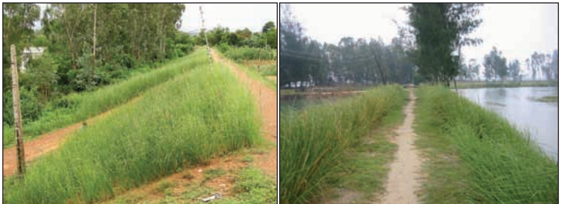
Picha ya 11: Kushoto: Vetiver iliyopandwa kwenye handaki la mtoni kandokando ya mto Tra Bong. Kulia: Mistari ikiwa sambamba na handaki la uzuiaji wa umunyu kandokando ya mto huohuo.
