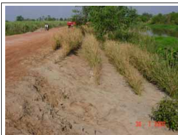
Hình 5.13. Nền đường trên đất chua phèn nặng ở Tiền Giang trước và sau khi trồng cỏ Vetiver.
