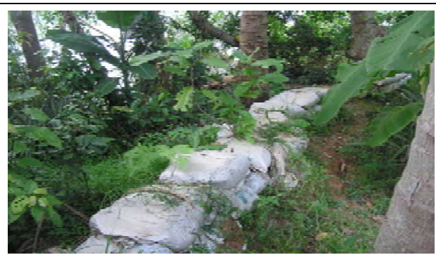
Hình 3.18. Một đoạn bờ sông Trà Khúc ở xã Bình Thới (Quảng Ngãi) bị xói lở nghiêm trọng (trái); Trước đây người dân vẫn dùng các bao cát để tạm bảo vệ bờ (phải).
