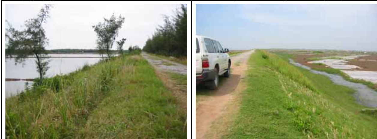
Hình 3.23. Trồng thử nghiệm cỏ Vetiver ở mái ngoài đê biển Hải Hậu (trái); Nhưng cỏ Vetiver đã được trồng bảo vệ mái trong đê biển từ trước đó 1-2 năm (phải).
