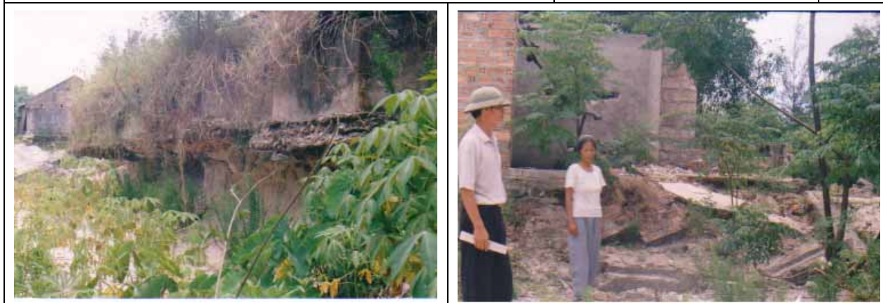
Hình 3.6. Cát chảy ở Lệ Thủy (Quảng Bình) năm 1999, làm trơ móng trạm bơm (trái) và phá sập ngôi nhà gạch ba gian của người phụ nữ này (phải).
