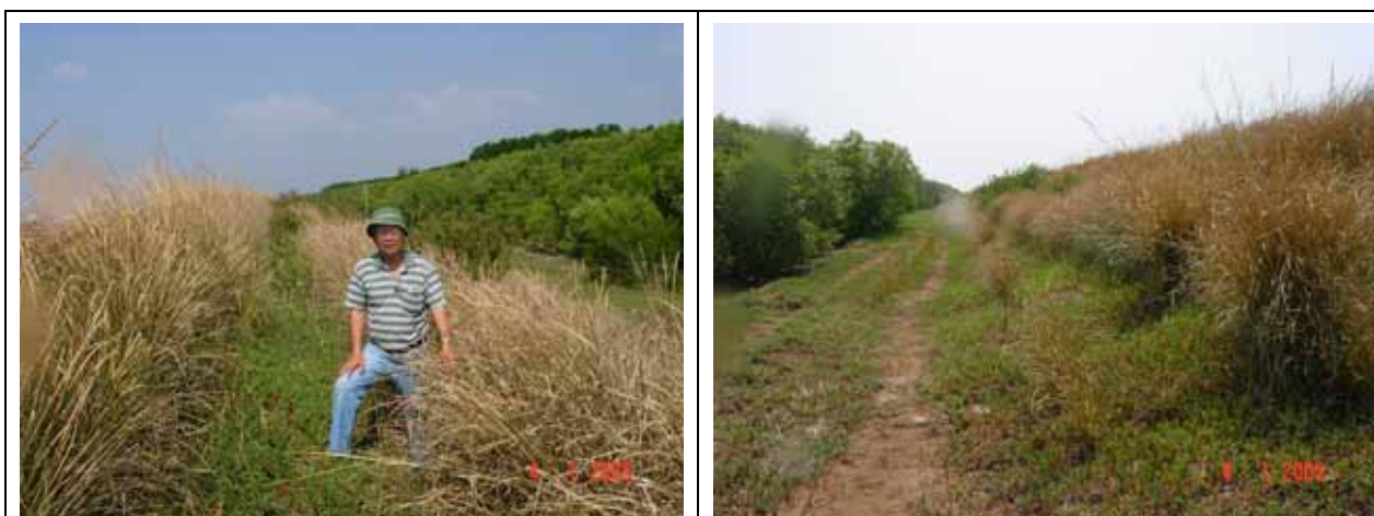
Hình 3.22. Cỏ Vetiver trên đất chua phèn hệ thống đê biển Gò Công, phía sau rừng được (trái), giúp giảm nhẹ xói lở mái đê và tạo điều kiện cho cây cỏ bản địa phục hồi (phải).
