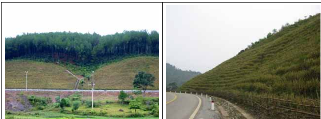
Hình 3.24. Cỏ Vetiver trồng bảo vệ taluy đường dọc tuyến đường Hồ Chí Minh.
