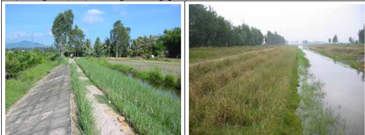
Hình 3.17. Bảo vệ mái trong một đoạn đê ngăn mặn khác (trái) và một đoạn kênh thủy lợi Thạch Nham (Quảng Ngãi) (phải).
