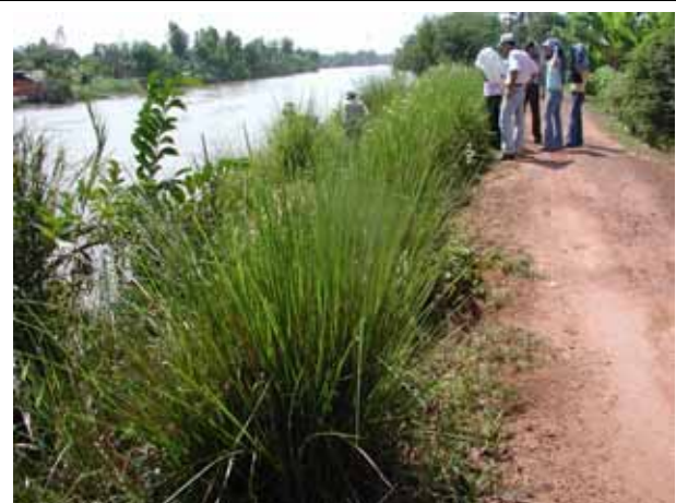
Hình 3.20. Cỏ Vetiver bảo vệ đê sông (trái) và bờ sông, bờ kênh (phải) ở An Giang.
