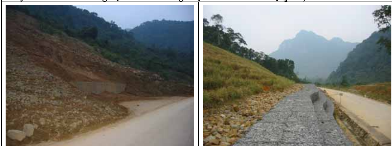
Hình 3.26. Taluy đường liên tục trượt lở ở đèo Đá Đẽo (Quảng Bình), đùn đất đá xuống đường (trái), nhưng cỏ Vetiver góp phần làm chậm và giảm nhẹ quy mô trượt lở (phải).
