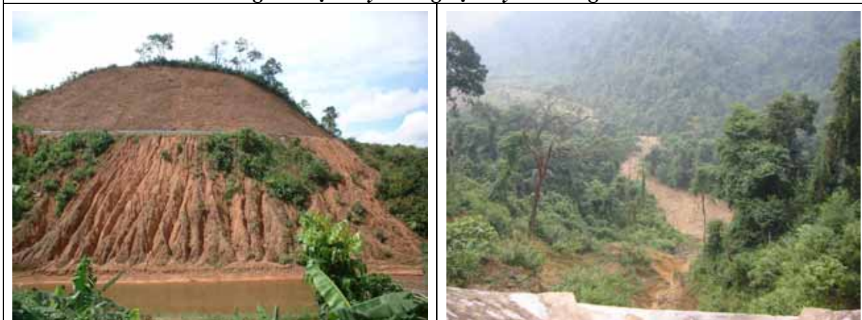
Hình 3.25. Đất đá thải ra bờ bãi khi làm đường có thể bị cuốn trôi theo sông suối (trái) và di chuyển rất nhanh xuống hạ lưu nếu không được cỏ Vetiver bảo vệ (phải).
