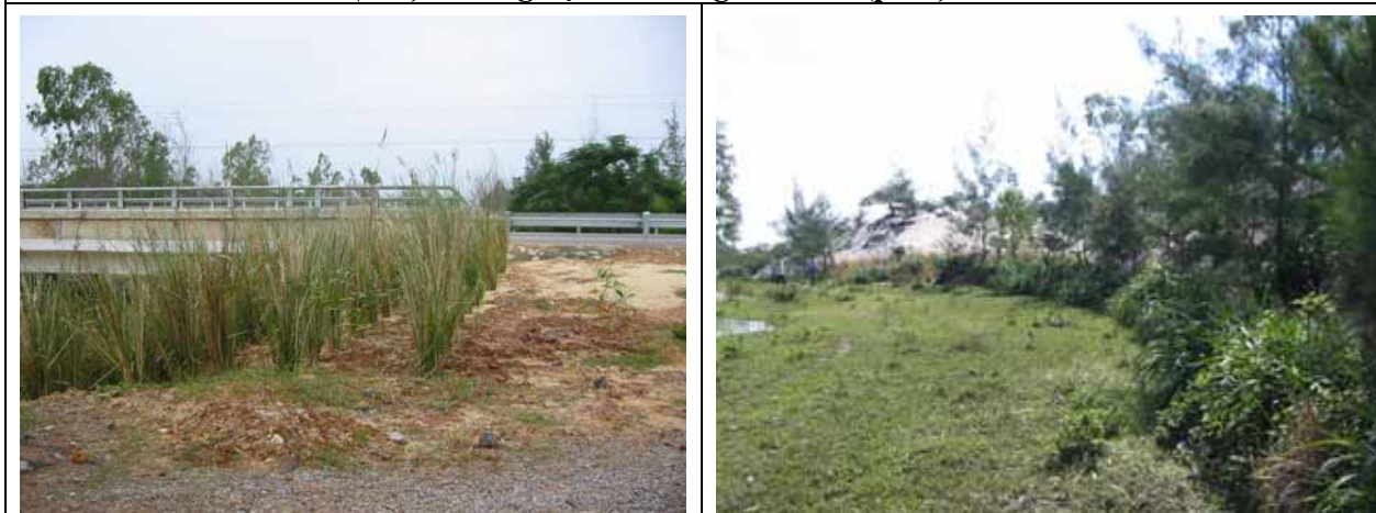
Hình 3.11. Bảo vệ móng cầu dọc quốc lộ 1A (trái); Các loài cây bản địa thay thế - Tháng 12/2004 (phải).
