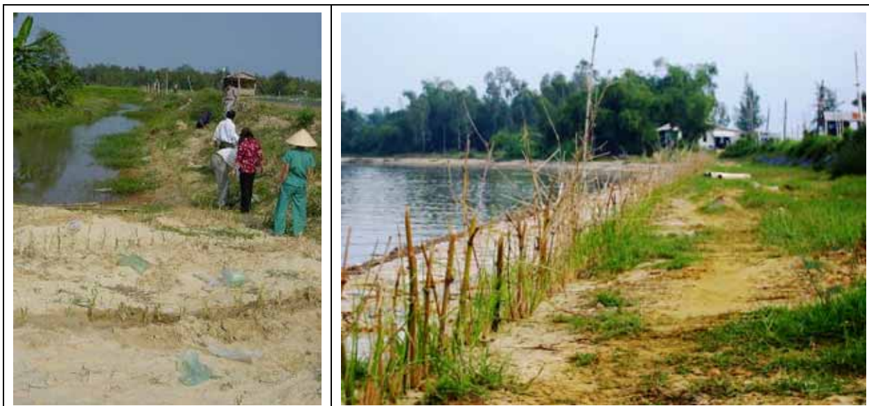
Hình 3.13. Trồng cỏ Vetiver cạnh đầm tôm, cắt ngang mương thoát lũ ra sông Vĩnh Điện (Đà Nẵng) - Tháng 3/2002 (trái); Kết hợp cùng kè đá bảo vệ bờ sông Vĩnh Điện - Tháng 11/2002 (phải).
