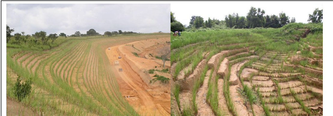
Barreras de vetiver protegiendo taludes de corte en autopista (izquierda) y, la estabilización de una cárcava(derecha), ambos en el Congo.
