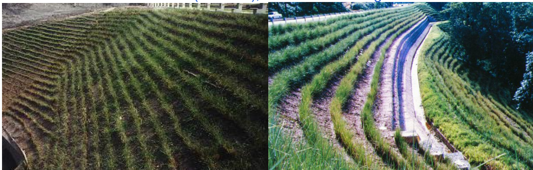
Barreras de vetiver protegiendo taludes de relleno, a la izquierda en autopista en El Salvador y a la derecha en Malasia.
