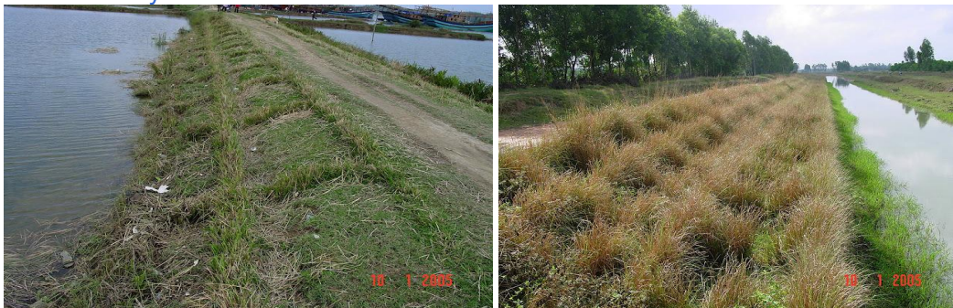
Protección de dique con patrón rectangular de barreras de vetiver (izquierda), y de banco de río (derecha), ambos en Vietnam, donde se han utilizado miles de km de barreras con este fin, protegiendo a las comunidades de desastres naturales.
