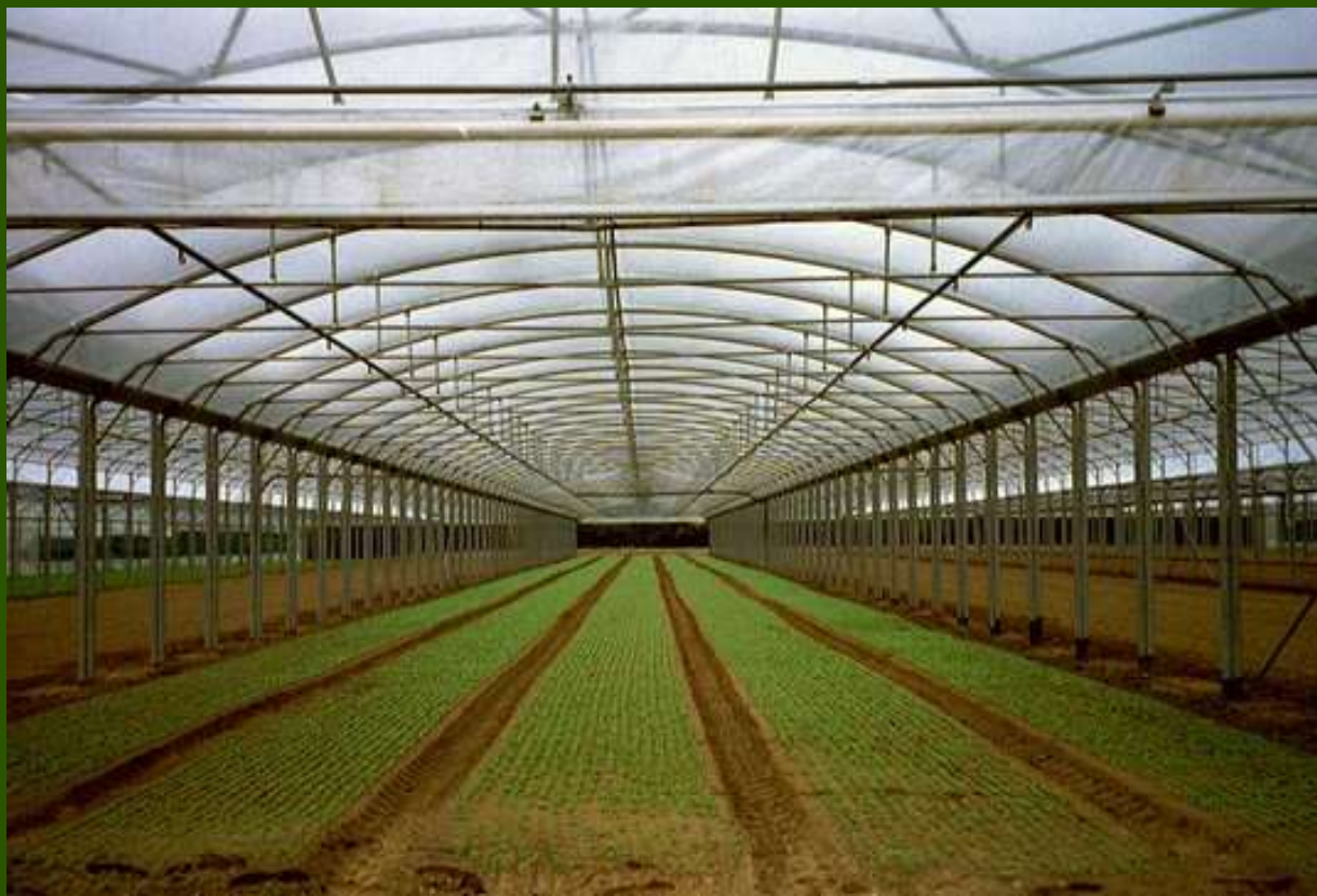
Exemple de Station d'Épuration de 2000 Eqh : Serre de 50m x 40 m.
