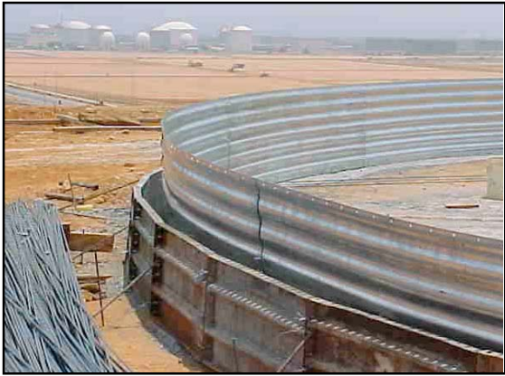
Etapa constructiva del tanque de almacenamiento para el agua de riego de las especies vegetales
