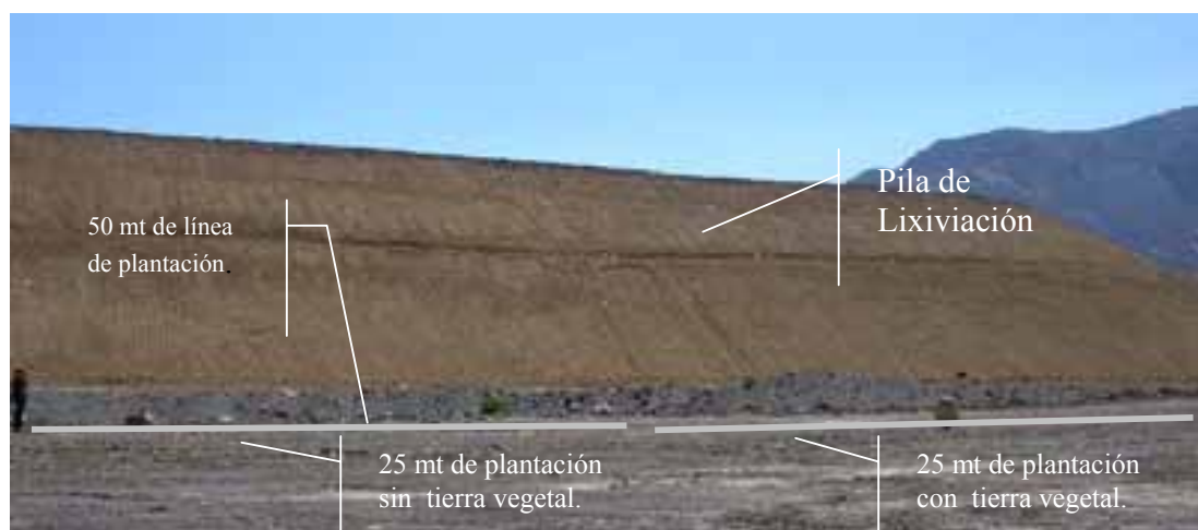
Foto 1: Ubicación y Características de la Prueba VGT.
