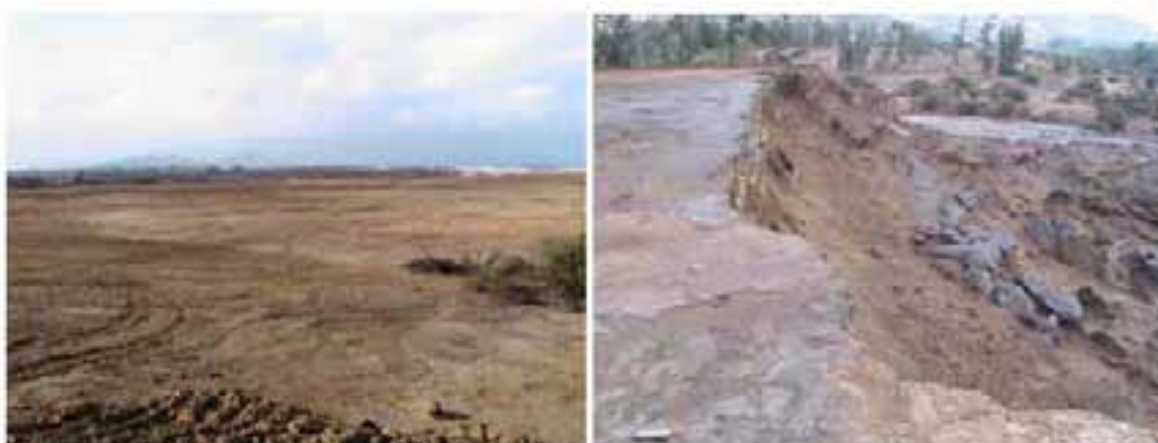
Foto 5: Tranques de Relave sin presencia de Vegetación y con problemas de Erosión
