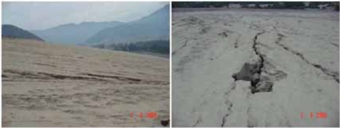
Foto 15: Características del Tranque en Mina El Soldado
