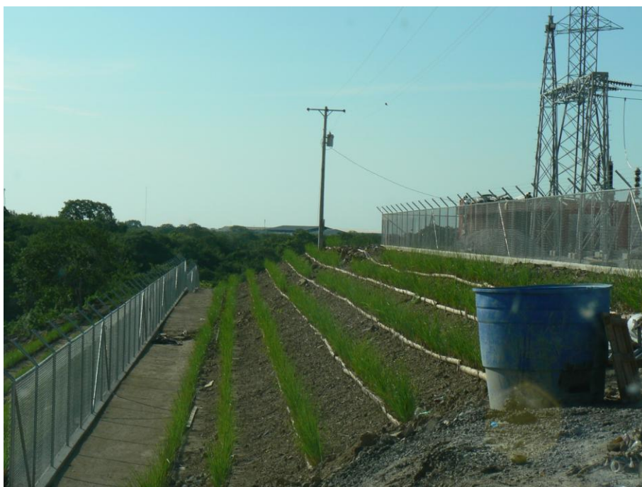
VETIVER EN MATERIAL DE RELLENO (CASCAJO)
