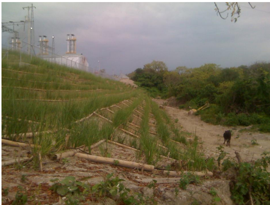
TALUDES DE RELLENO ESTABILIZADOS CON VETIVER
