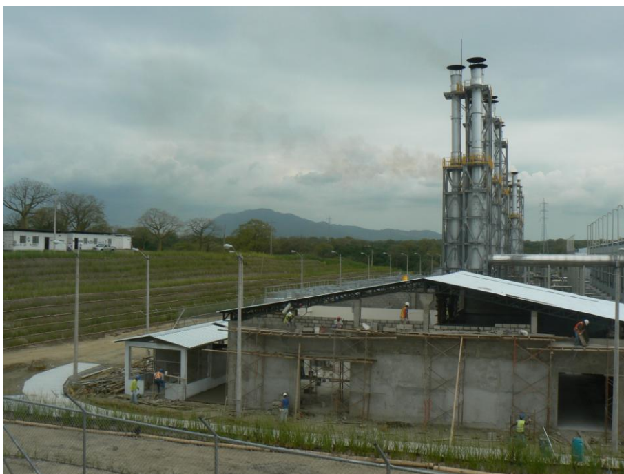
RECUBRIMIENTO VEGETAL EN TALUDES
