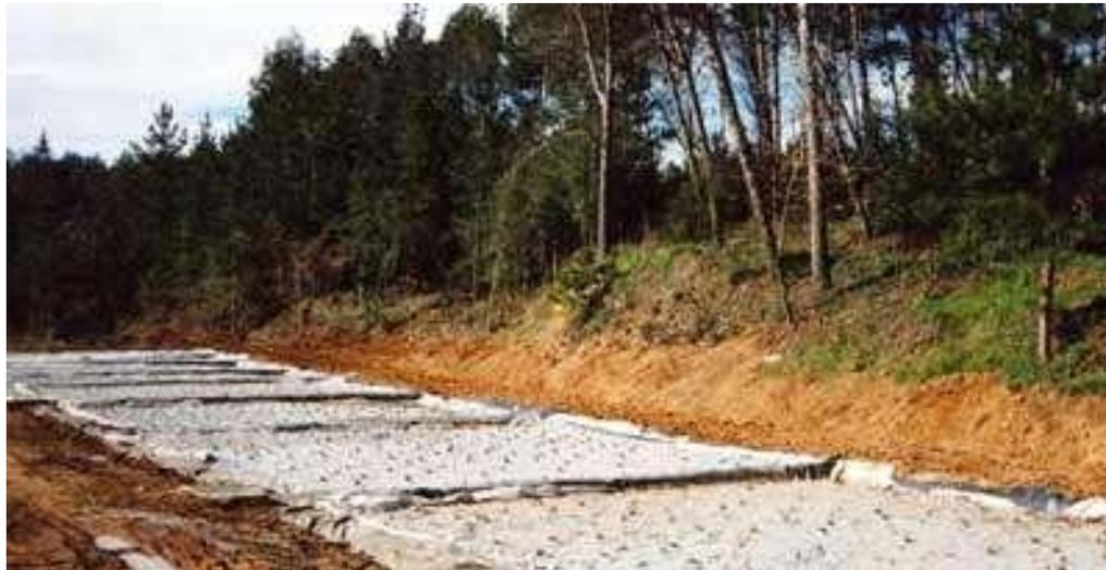
Se les realiza un revestimiento con una lamina plástica que no deje filtrar las aguas.
