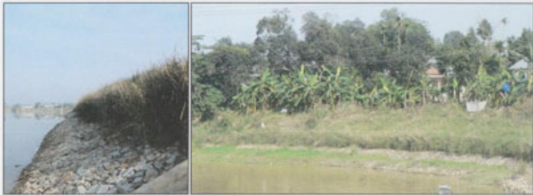
**Foto 10: Esquerda: Vetiver e enrocamento de pedras (em cima) e com estrutura de concreto (em baixo) protegendo um declive em uma represa; direita: uma curva sobre plantações de Perfume nas bordas de um rio em Hue.**
