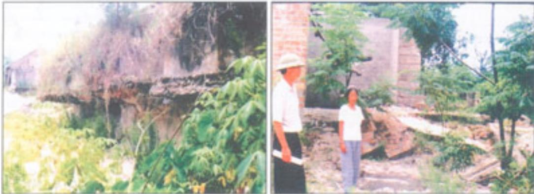
**Foto 2: Fluxos de areia em Le Thuy (Quang Binh) em 1999: a fundação de uma estação de bombeamento (esquerda) e a fundação da casa de três quarto desta mulher foi danificada pelo movimento da areia (à direita).**
