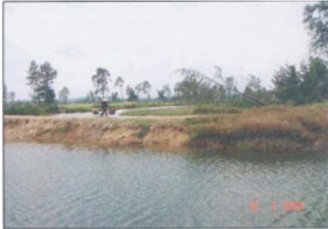
**Foto 23: A seção a direita da estrada rural em Quang Ngai é protegida por barreiras de vetiver, na seção a esquerda está desprotegida.**
