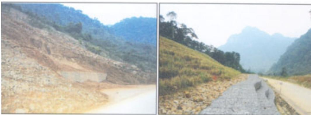
**Foto 21: Da Deo Pass, Quang Binh: Esquerda: Cobertura vegetal é destruída, revelando falhas feias e contínuas de cortes nas encostas; direita: Linhas de Vetiver no topo da encosta espremem muito lentamente para baixo, reduzindo consideravelmente a massa que falhou.**
