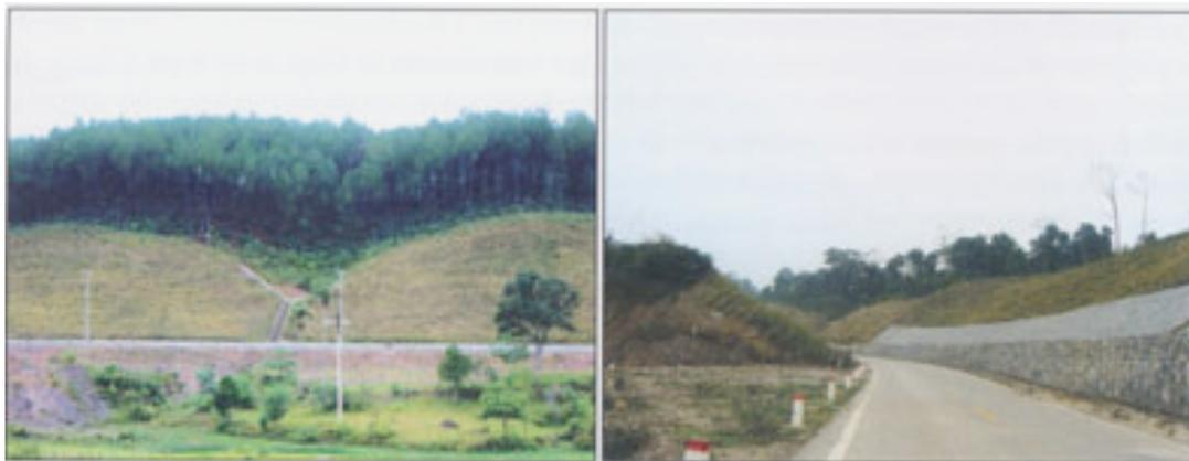
**Foto 19: Esquerda: Plantas de Vetiver estabilizando cortes (rachaduras) ao longo das encostas da Rodovia (auto-estrada) da Cidade de Ho Chi Minh; direita: a planta sozinha e em combinação com medidas tradicionais.**
