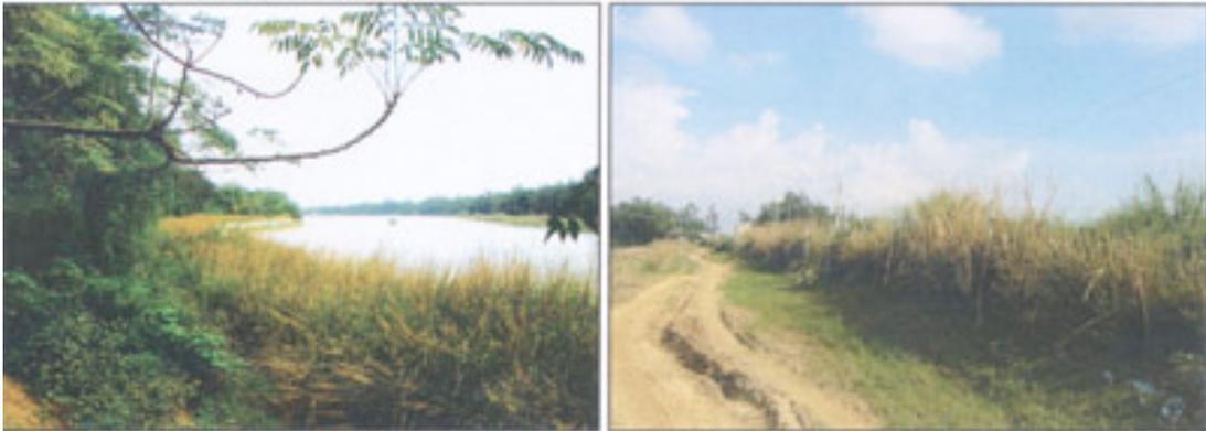
**Foto 9: Esquerda: Dezembro de 2004: Vetiver, combinadas com enrocamento de rochedos, floresceram após duas épocas de inundação (Da Nang); direita: plantadas por agricultores locais, a vetiver protegendo seus tanques de camarão.**
