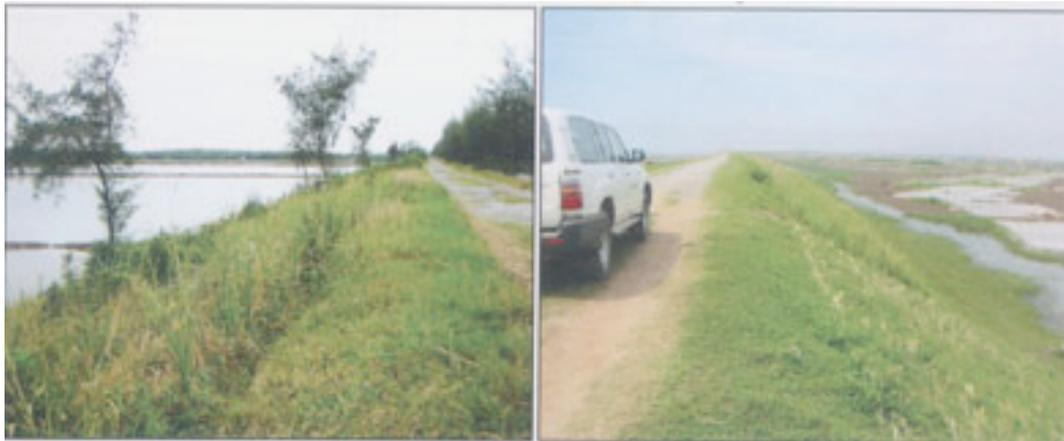
**Foto 18: No Vietnã do Norte; esquerda: Gramas de Vetiver plantadas no lado exterior de um dique construído recentemente no mar da província de Nam Dinh; direita: no lado interno do dique, plantada pelo departamento local de Diques.**
