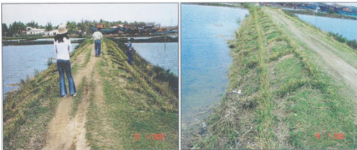
**Foto 22: Barreiras de Vetiver, instaladas em uma comporta de cruzamento padrão, protegendo os diques de uma lagoa de camarão em Quang Ngai.**
